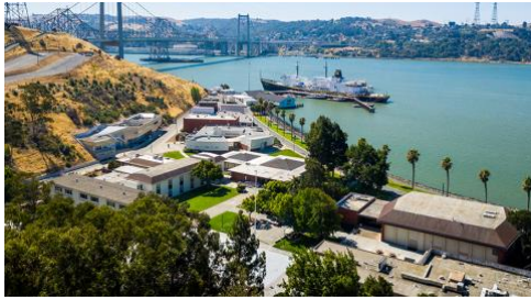
Fig. 0-34. Cal Maritime Campus
